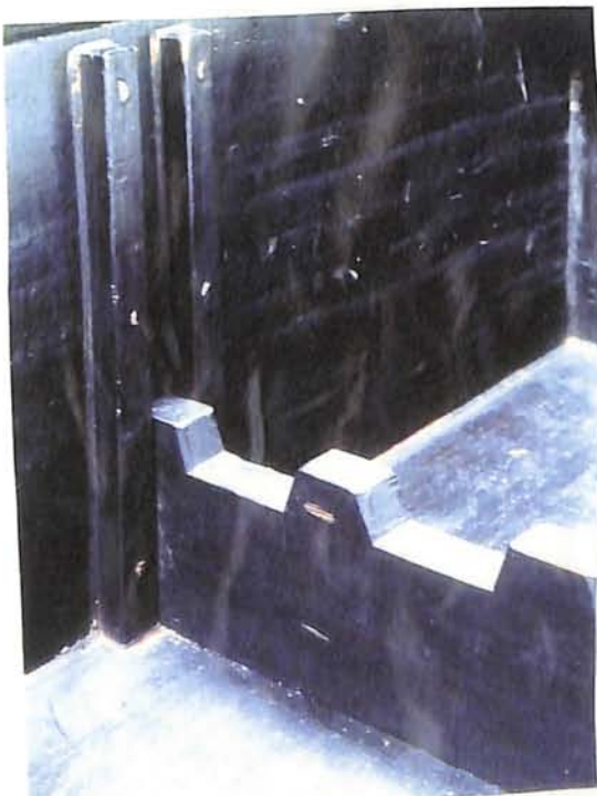
写真 (10) 前部より見た 木凹形と横壁 に沿ってある溝
