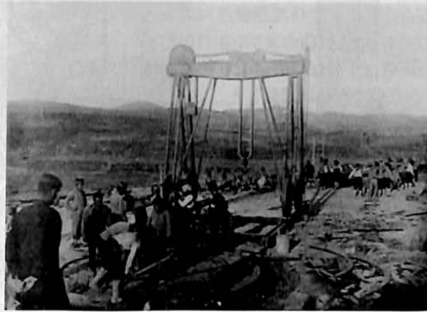
日露戦争における28糎の砲床築設作業。
