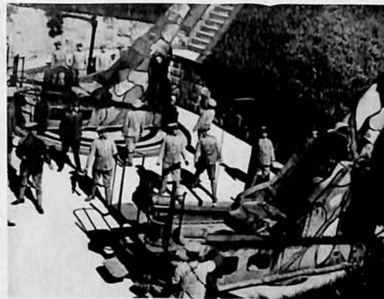
迷彩塗装を施した28榴の3葉。 海上からは見えないので露天砲が上空から識別されないように備えたもの。 時代は新しい。
